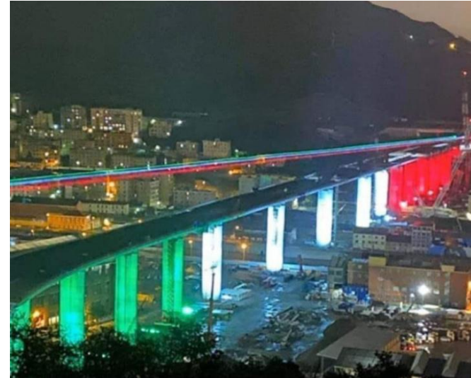
Nuovo Ponte di Genova - 2020
